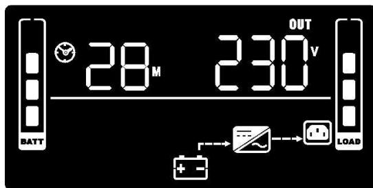
Figura 17: Display funzionamento a batteria
